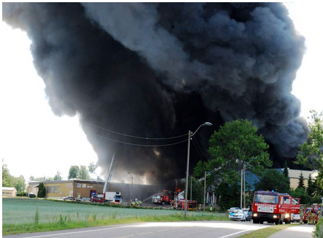
I etterkant av den store brannen i Basa-Huset i Tønsberg i juli er det blant annet kommet frem at eier ikke har sikret at sprinkleranlegget er funksjonsdyktig til enhver tid. Foto: Marikken Wulff Wathne / Tønsbergs Blad
