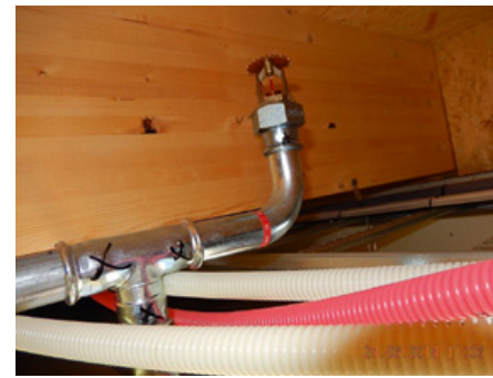
En av få sprinkler over himling - dårlig dekning grunnet høye dragere.
