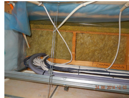
Kabelbro over himling - kun noen steder sprinklet.
