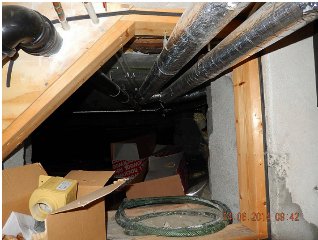
Del av kjeller ikke sprinklet og ikke brannskille.
